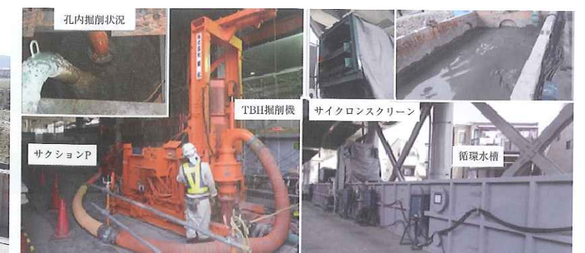
写真-5 TBH掘削機による施工状況
