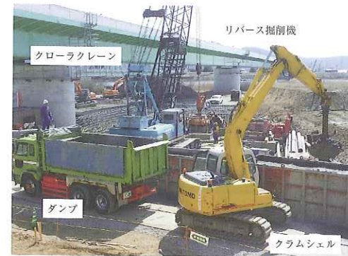
写真-4 リバース掘削機による施工状況
