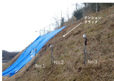
図3 切土斜面及び計器設置状況
