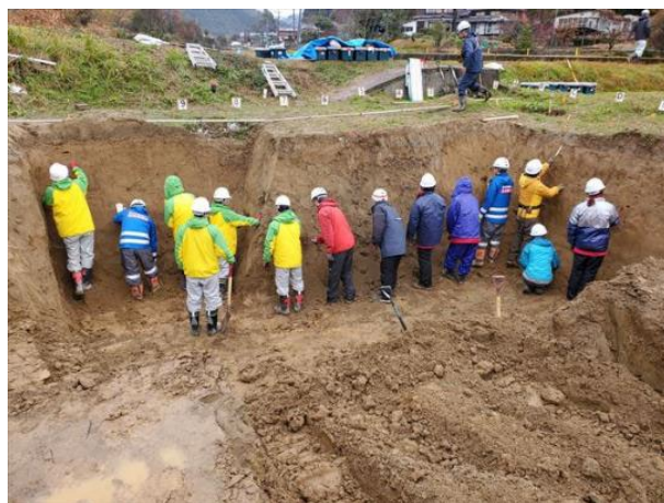
図-11 人海戦術での観察断面の作製状況
