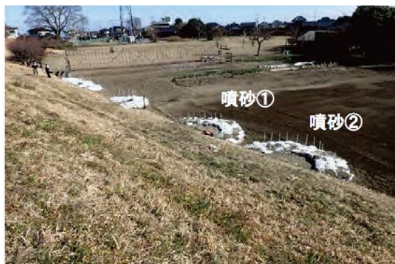
図一 鬼怒川で発生した噴砂と応急対策工の状況 9)
