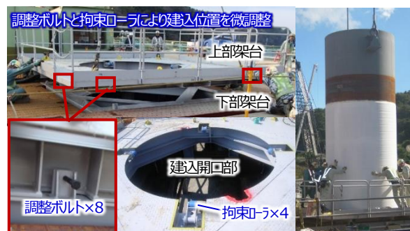
図-3 上：掘削用架台，下：建込用架台および建込状況
