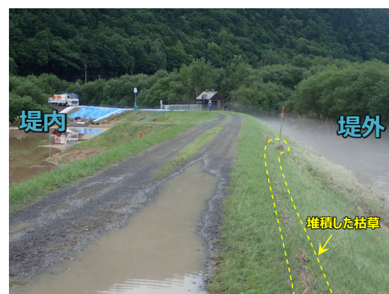
図-6 表法面に堆積した流下物の状況の例
