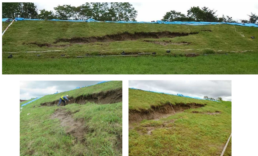
図-3 釧路川で発生した法面変状の状況 7)
