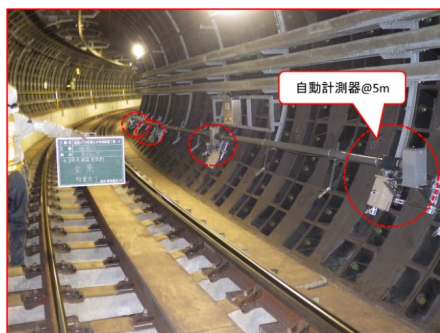
図-14 地下鉄構内の計測機器設置状況 6)
