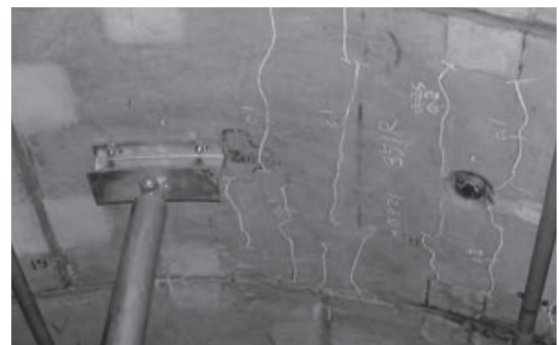
写真-1 トンネルの天端付近の状況 4)
